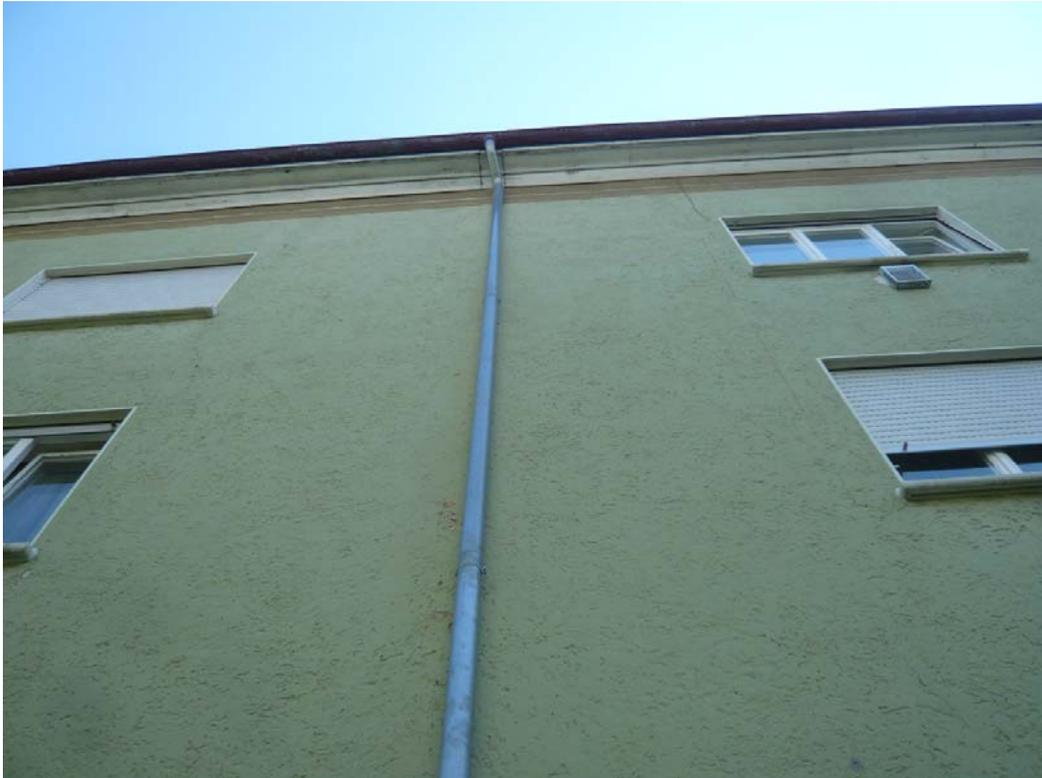
Abbildung 42: Westfassade mit Traufgesims und Abgas  ffnung von Gaseinzelofen
