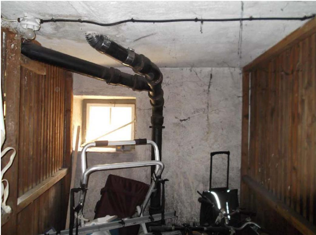
*Abbildung 62: Abwasserinstallation im Keller*
