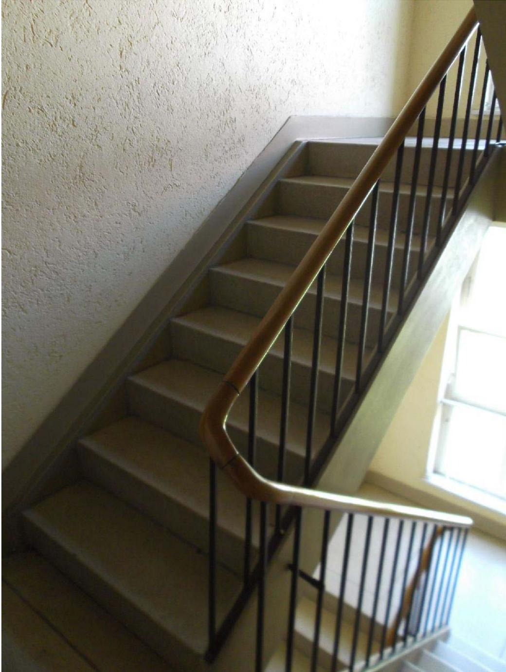
Abbildung 10 Treppen aus Betonwerksteinstufen
