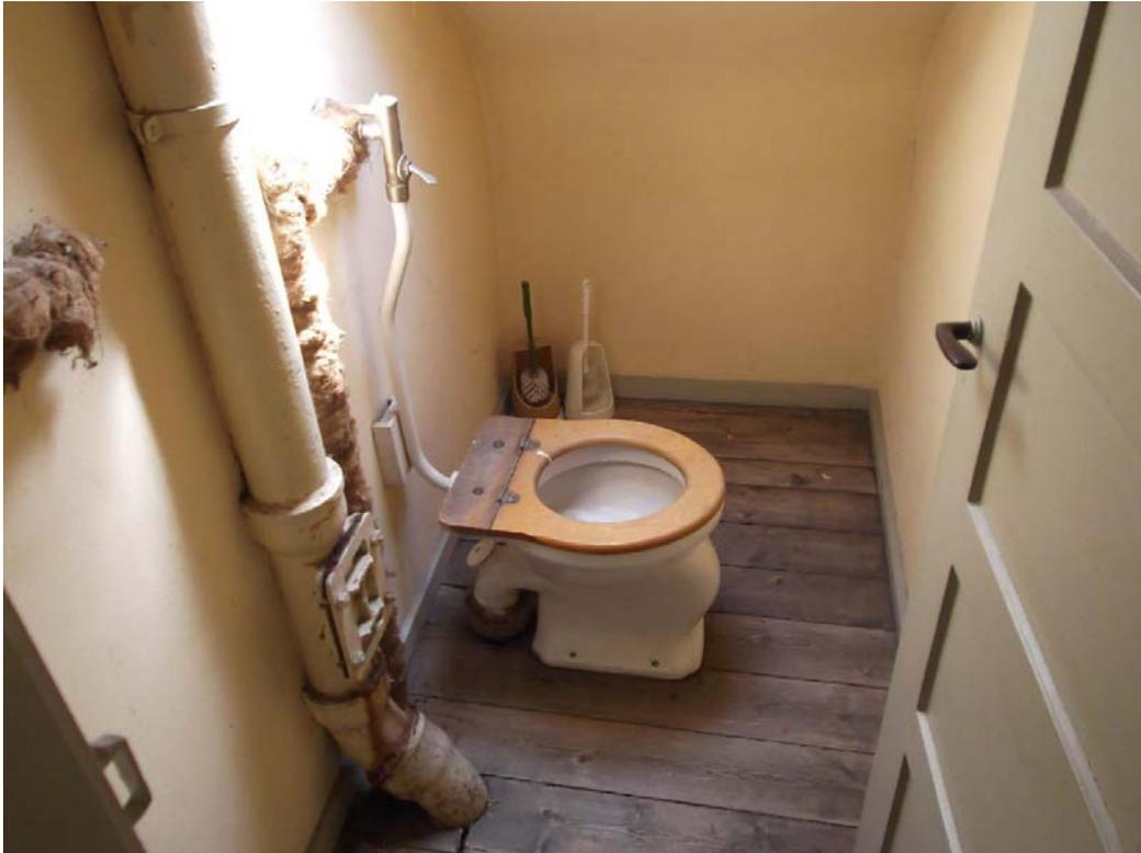
*Abbildung 61: Über Dach führendes Entlüftungsrohr mit Putzstück (Reinigungsöffnung) und historisches WC im Dachgeschoss*
