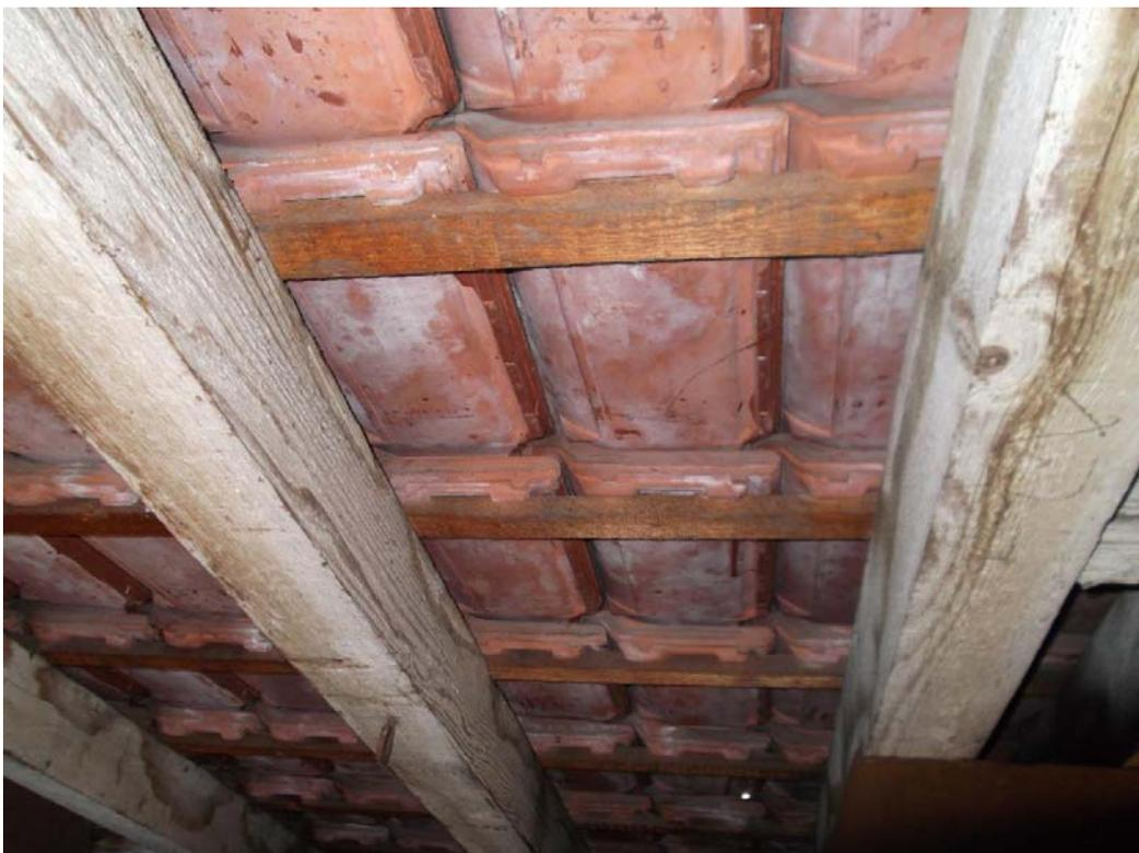
Abbildung 33: Sparren und Ziegeluntersicht im Bereich des Spitzbodens
