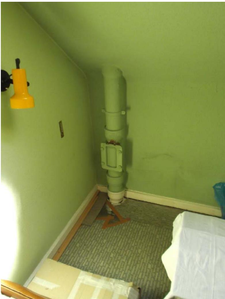
Abbildung 28: Dachkammer, Dunstrohr mit Putzstück
