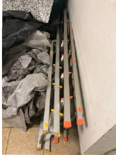
Neben alten Baueimern oder Styroporblöcken wurden unzulässige, alte abgewirtschaftete Haushaltsleiter verwendet.
