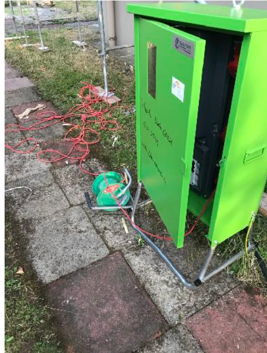
Offener Baustromverteiler über Feiertage
